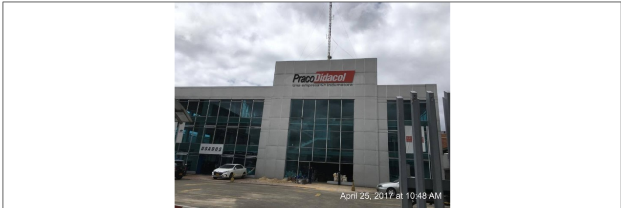
Fotografía No. 4 vista del aviso en fachada ubicado sobre la carrera 70 el cual no cuenta con solicitud de registro.
