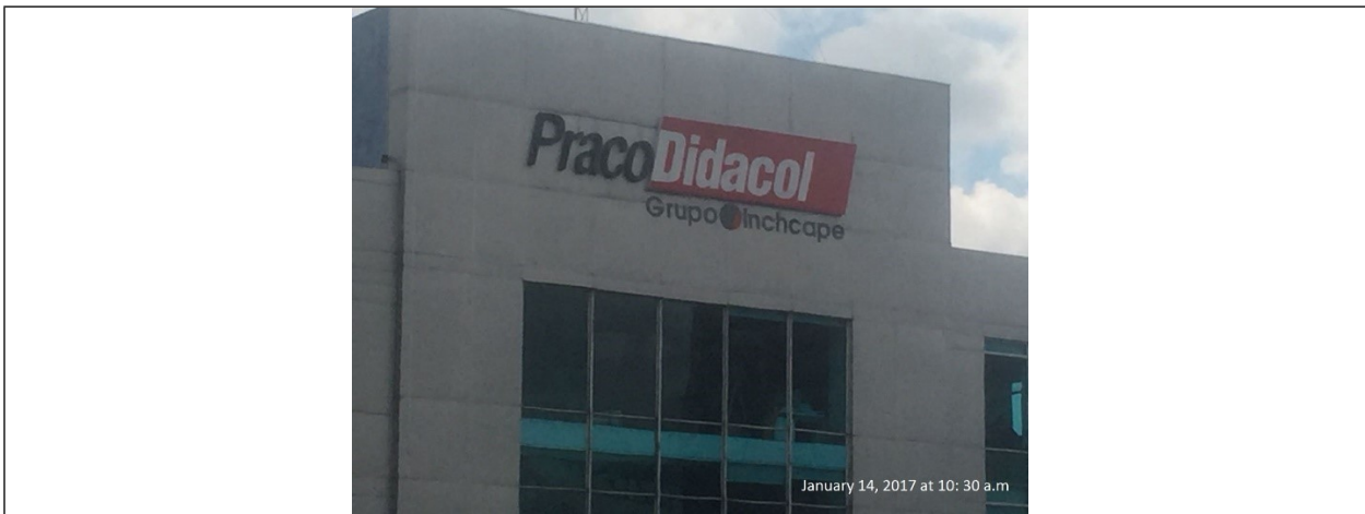
Fotografía No. 5 Vista del aviso en fachada ubicado sobre la carrera 70, el cual no cuenta con solicitud de registro.
